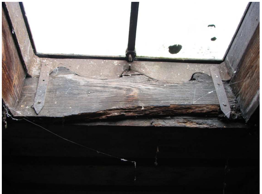
Fot. 24 Olsztyn, Kortowo, Plac Łódzki 2, wyłaz dachowy, widok od wewnątrz, zbliżenie
