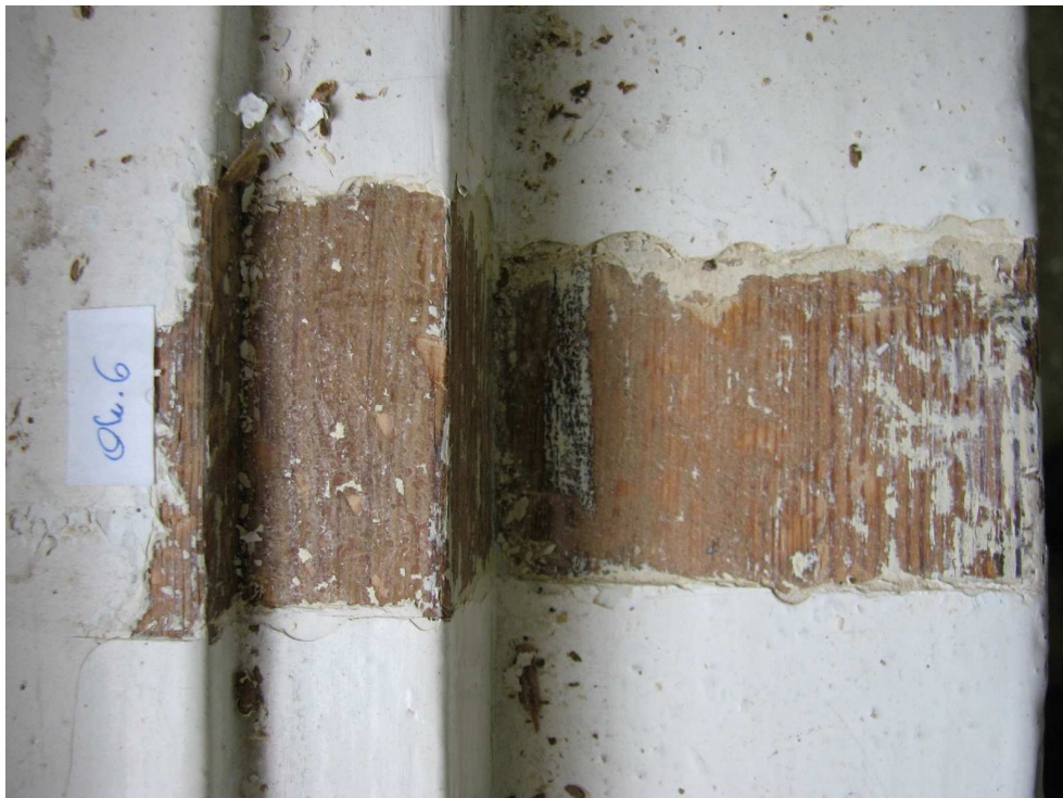
ODKRYWKA 3 Ościeże oraz parapet drewniany, widoczny mazerunek w kolorze ugrowym na ościeżnicy okna, parapet- brak mazerunku
