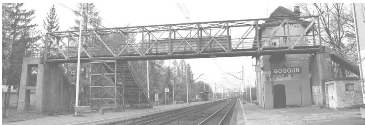
Rys. 1. Widok na kratownicową kładkę dla pieszych. Stacja kolejowa Gogolin
