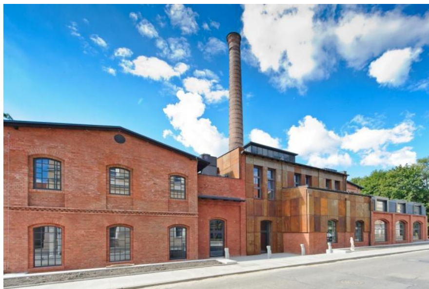
Rys. 6 Zdjęcie zmodernizowanej Starej Kotłowni UWM
