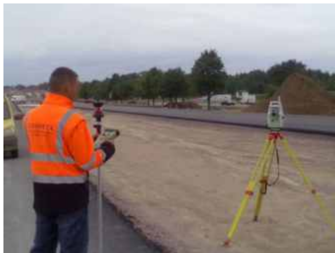
Geodeta z tachimetrem jednoosobowym
