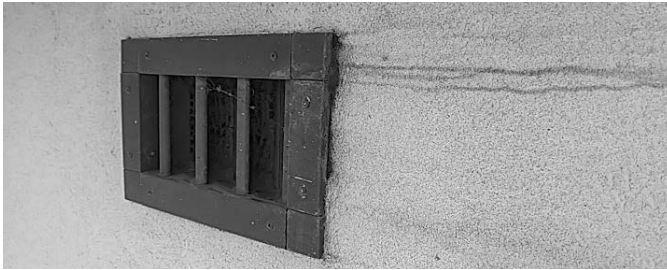
Rysunek 3. Widok zabrudzonej czerpni wentylacyjnej
