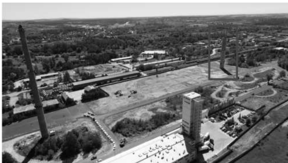
Rysunek 3. Teren Fabryki Tlenku Glinu w czasie prac rewitalizacyjnych
