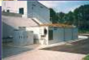
biofiltry do dezodoryzacji gazów odlotowych
