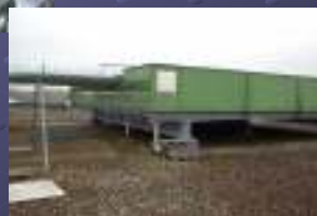
biofiltry do dezodoryzacji gazów odlotowych
