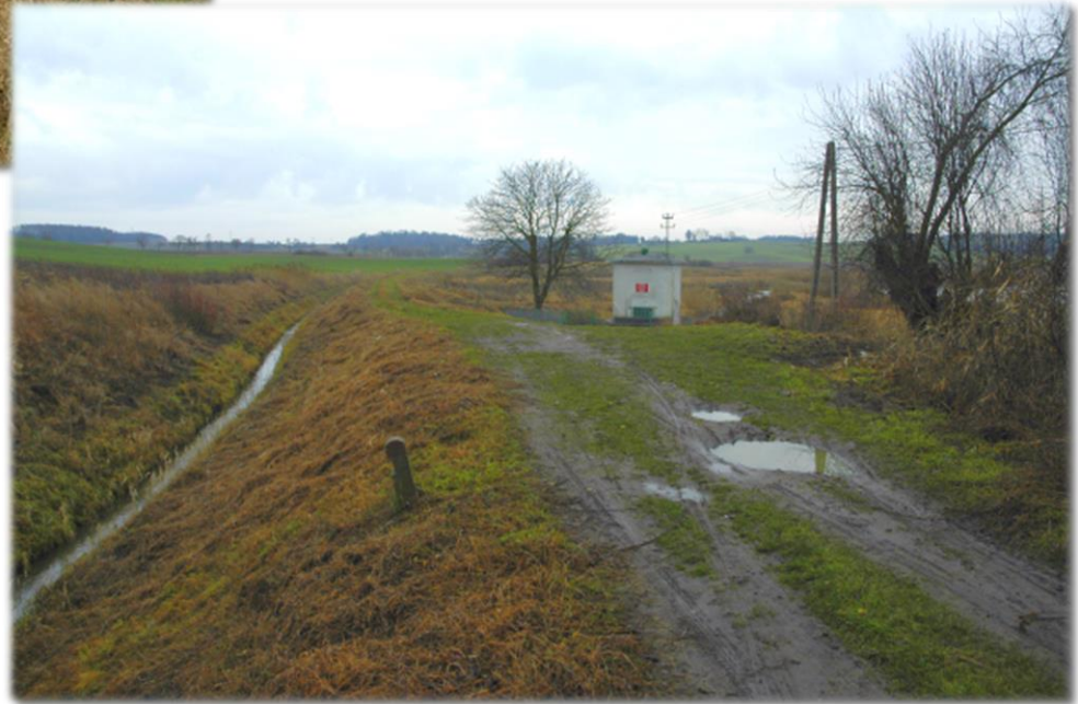
Odwodnienie wspomagane systemem przepompowni
