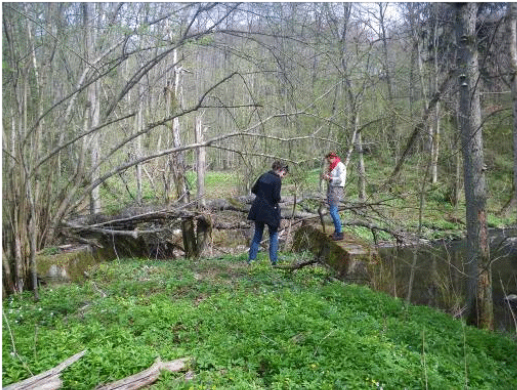
Ryc. Wstępne zapoznanie się z obiektem badań – pozostałości dawnego mostu na Walszy, maj 2010.
